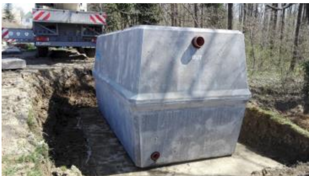
Eleveniszapos szennyvíztisztító rendszer – SBR technológia
